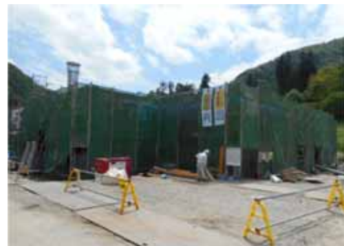
改修工事が進む、ぽかぽかランド美麻
